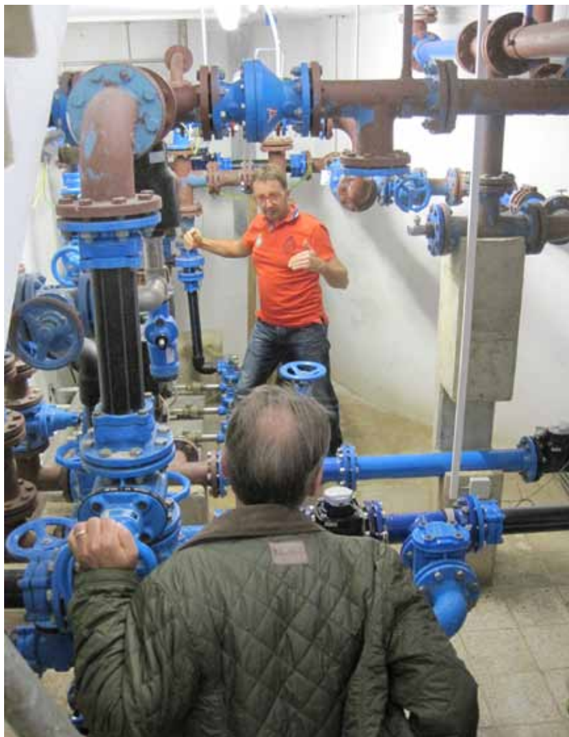
Wassermeister Robert Sudy erklärt dem Vorstand die Anlage im Hochbehälter
